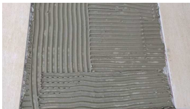
圖 8 整溝方式-網狀刮痕(資料來源:105/05/10 訪談工程行 12 新建外牆_筆者拍攝)
